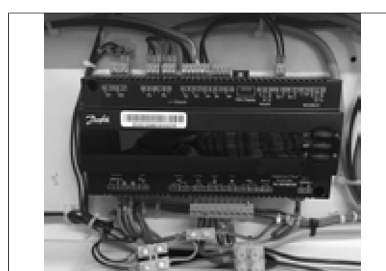
Billede 5: Midlertidig ledningsføring
