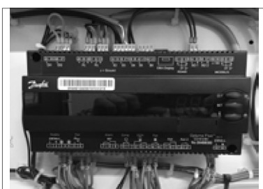
Billede 4: Normal ledningsføring
